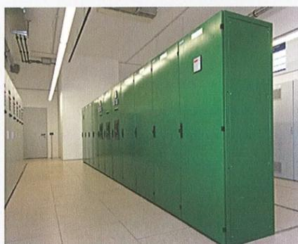
10 kV-Kabel sowie die notwendigen Schutz-, Mess- und Steuereinrichtungen inkl. dem Übergabeschrank an die Leittechnik.
