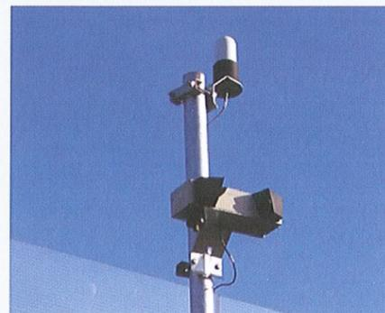
Ausfahrtrampen. Die Verkehrsdatenerfassung erfolgt über 142 Radardetektoren, welche mit Infrarotsensoren kombiniert sind. Die Verkehrsdaten werden im 15-Sekunden-Intervall erfasst und an die Unterzentrale übertragen. Es werden die Anzahl der Kraftfahrzeuge und die mittlere Geschwindigkeit für 2 Fahrzeugklassen ermittelt.
