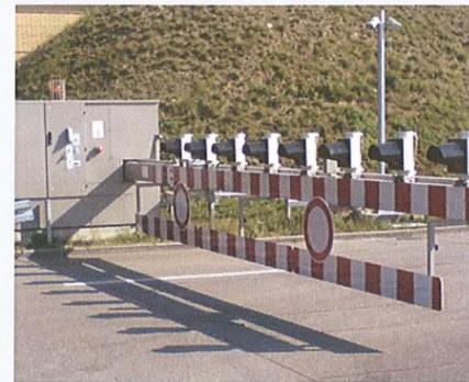
Sperrschranken an den Autobahn-Einfahrten sowie Feuerweherschranken im Mittelstreifen der Autobahn vorhanden. Die drei Feuerweherschranken sowie zwei Einfahrt-Sperrschranken öffnen und schließen sich vertikal die übrigen Schranken werden horizontal geschwenkt.
