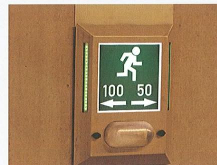
Betrieb, die Orientierungsbeleuchtung wird nach Auslösung eines Brandalarms in beiden Tunnelröhren eingeschaltet. Ebenso wird bei einem Brandalarm die visuelle Leiteinrichtung (selbstleuchtende Markierungselemente, LED weiß) im linken und rechten Straßenbord beidseitig eingeschaltet. Diese unterstützen die Orientierung bei Verrauchung. Somit wird die Selbstrettung der Tunnelnutzer sich schnell in Sicherheit zu bringen gefördert.
