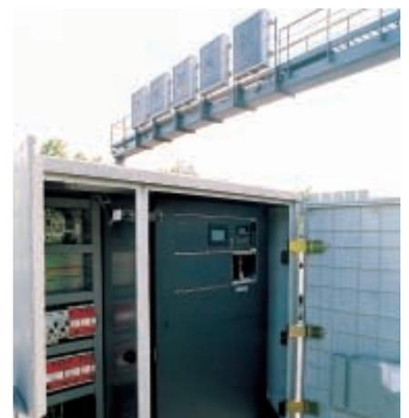
Streckenstation vor einem Anzeigequerschnitt
